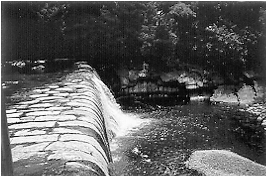
Fig. 2 - La presa seicentesca sul torrente Bargaglino, oggi non più utilizzata. Si notano gli strati del calcare del Monte Antola che si immergono nell'acqua.
