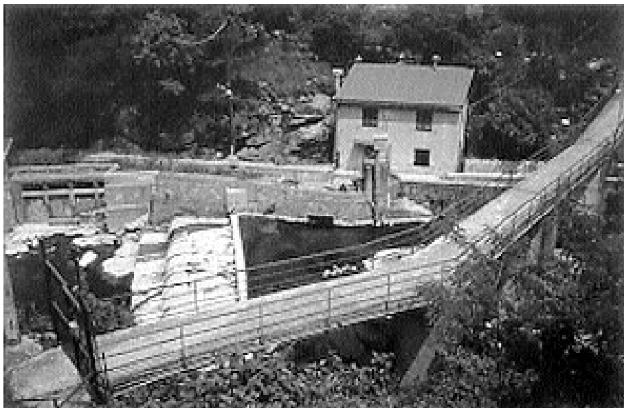
Fig. 3 - La paratoia rotante sulla presa seicentesca, con l'antica abitazione del custode.
