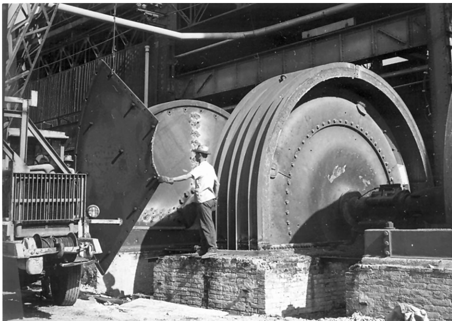
Fig. 1 - Una delle grandi turbine idrauliche che azionavano le presse delle Acciaierie di Terni (in fase di demolizione, anno 1957).
