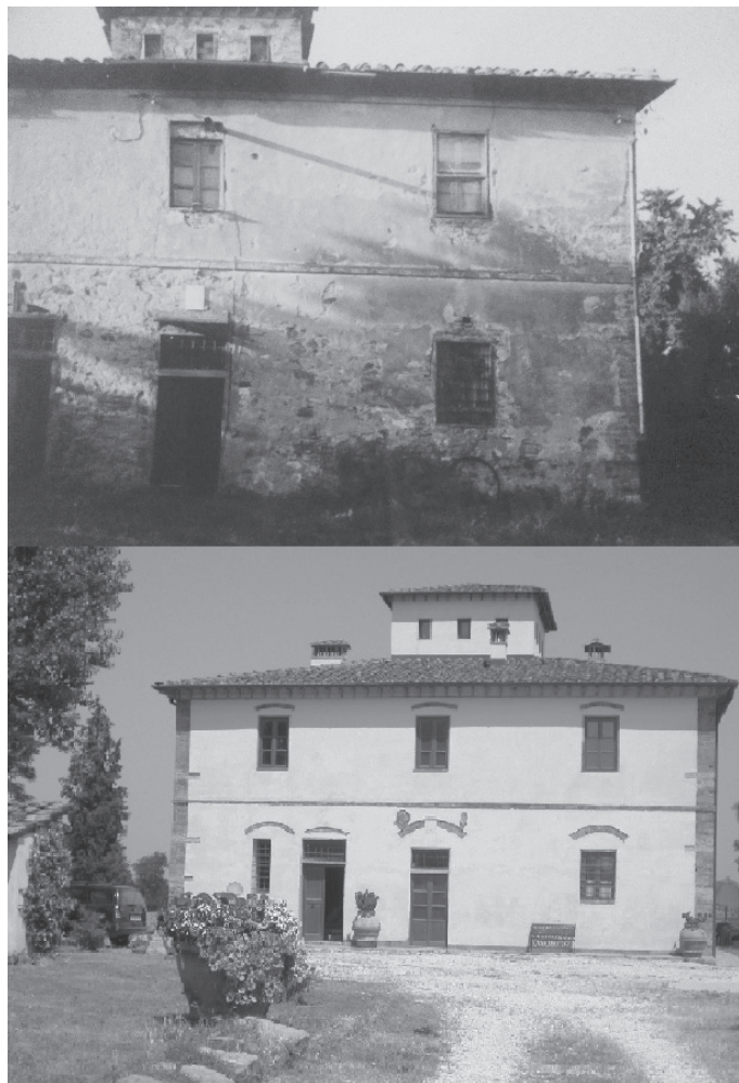
Figura 3. Esempio di casa podereale a Fabbrica di Pèccioli (Valdera), ricostruita dopo il terremoto del 1846, prima e dopo la ristrutturazione e la destinazione ad agriturismo avvenute nel 2000. Fonte: Podere I Moricci, Fabbrica di Pèccioli (Pisa).
