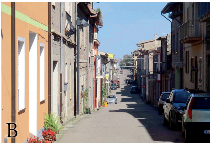
Tavola 1 rapporti con gli spazi esterni. A. veduta dalla periferia sud-orientale del centro abitato; B. edifici privati del centro abitato moderno, costruito al di fuori del centro storico. Fotografie: Fabio Parascandolo.
