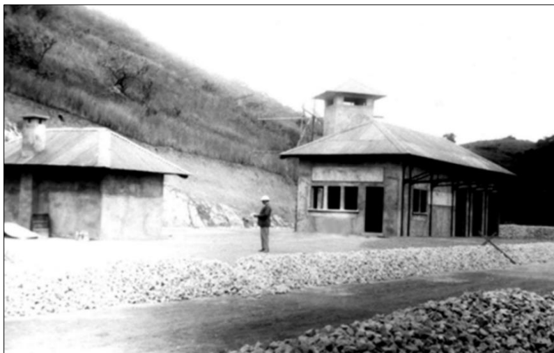
Figura 6. Stazione costruita dall'impresa Botalla in Cina (fonte: Centro di documentazione sull'emigrazione – Ecomuseo Valle Elvo e Serra, Biella)
