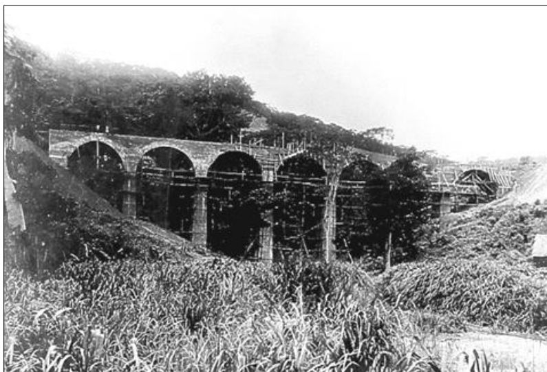
Figura 7. Viadotto costruito dall'impresa Botalla in Cina (fonte: Centro di documentazione sull'emigrazione – Ecomuseo Valle Elvo e Serra, Biella)
