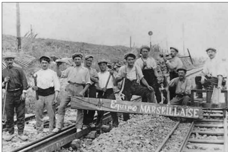
Figura 2. Operai italiani impegnati nella costruzione di una ferrovia nella Valle del Rodano (fonte: Centro di documentazione sull'emigrazione – Ecomuseo Valle Elvo e Serra, Biella)
