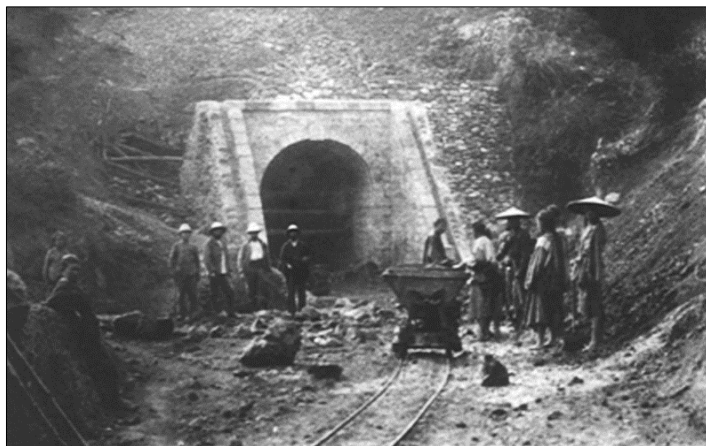
Figura 4. Operai dell'impresa Valpreda e C. al lavoro sulla linea del Tonchino (fonte: Fondazione Sella, Biella; foto Battista Savoia)
