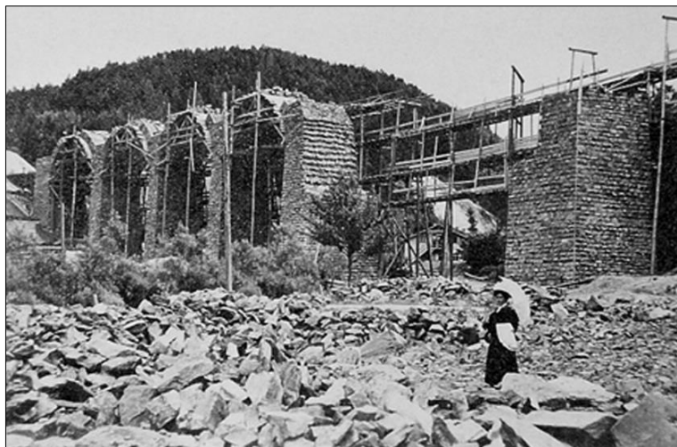
Figura 1. Viadotto costruito da impresa italiana nell'Anspag (Austria; fonte: Centro di documentazione sull'emigrazione – Ecomuseo Valle Elvo e Serra, Biella)
