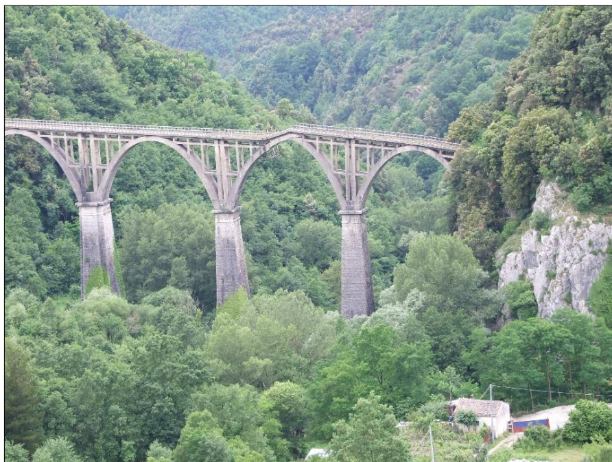
Figura 8. Il viadotto Serra oggi (fonte: GEOCART SpA)
