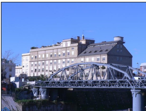
Figura 9. Il complesso dei Mulini Biondi e il ponte dell'Industria (foto MARINA MARCELLI, 2010)
