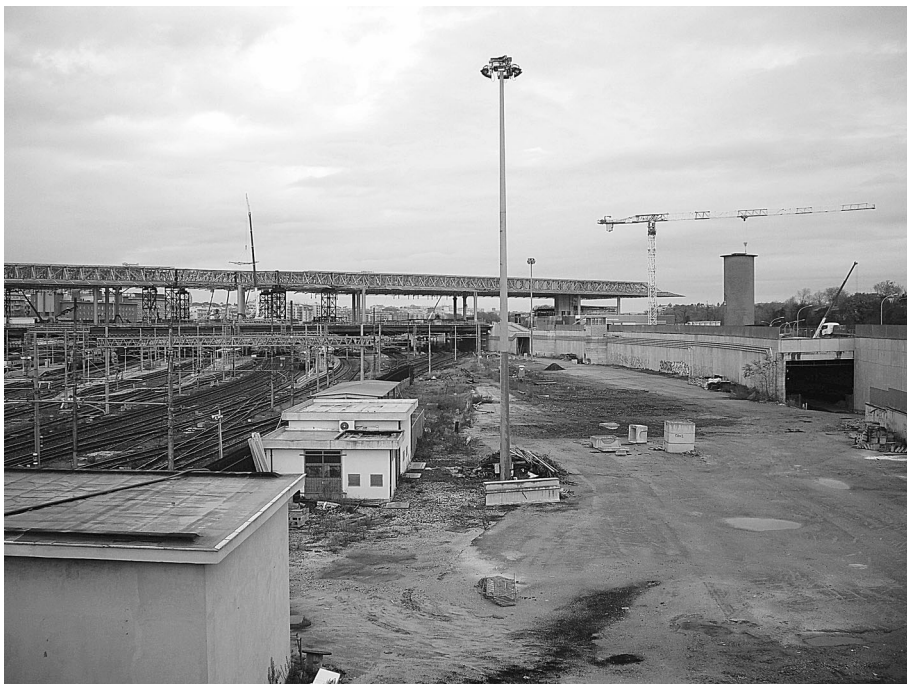
FIG. 3. Stazione Tiburtina: il nuovo “ponte” in costruzione
