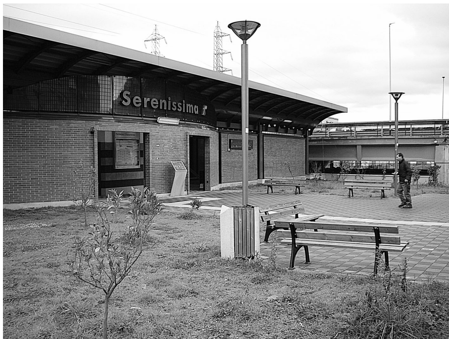
FIG. 8. Stazione Serenissima e viadotto dell'omonima via
