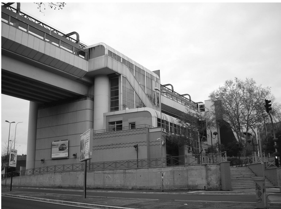
FIG. 10. La stazione Valle Aurelia, su viadotto
