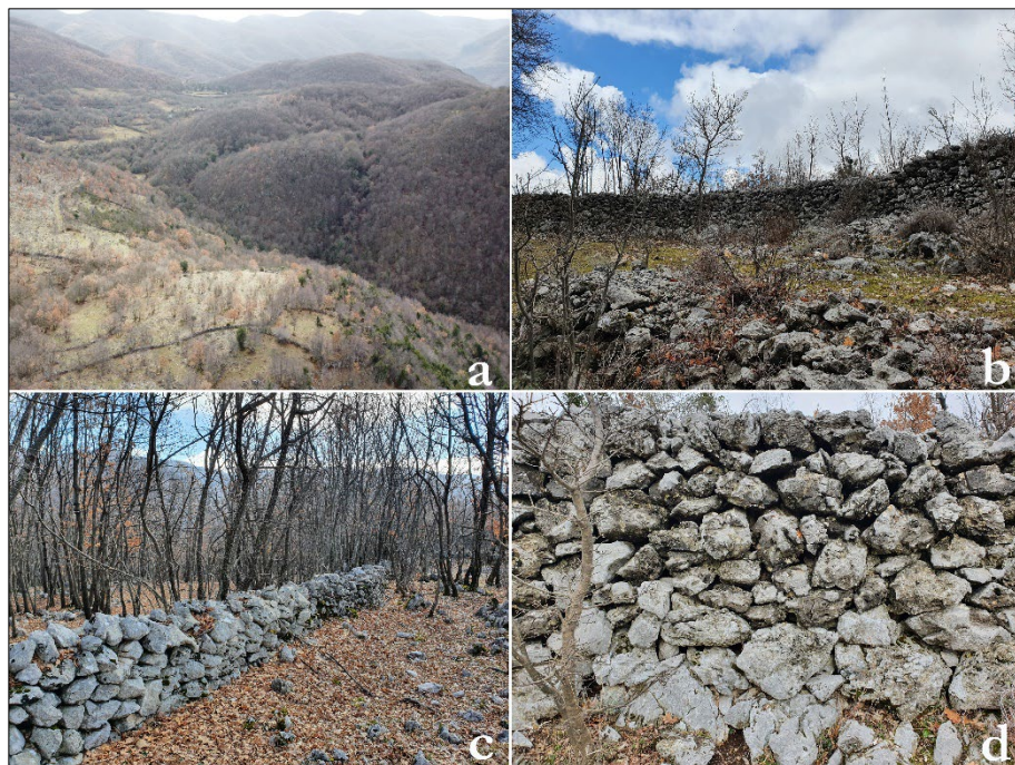
Figura 4. I muretti a secco nel territorio di Monteflavio. a) Recinzioni per attività agricole e per stabulazione; b) Muro di recinzione; c) Muro di delimitazione confine; d) Dettaglio della tecnica edilizia a secco in pietra calcarea locale (foto Martina Bernardi)
