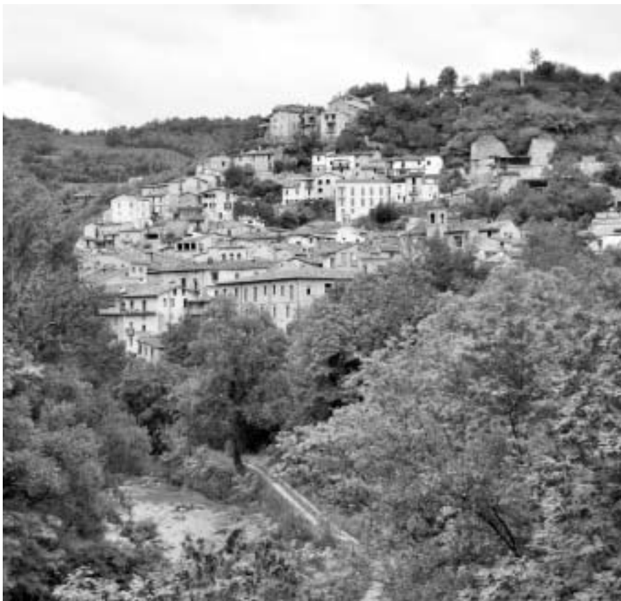
Fig. 1. Veduta di Montorio e delle sponde del fiume Vomano, nell'angolo in alto a destra si possono notare i ruderi del Forte San Carlo (foto A. D'Ascenzo, 2010)
