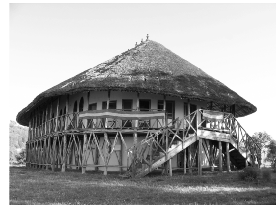
Fig. 1. Il Ristorante-Conference Hall dell'Ankober Palace Lodge
