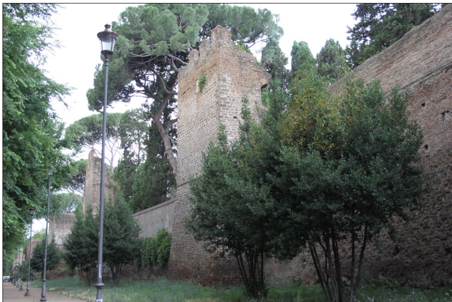
Figura 12. Mura Aureliane, fronte esterno da via del Campo Boario (foto Marina Marcelli, 2017)
