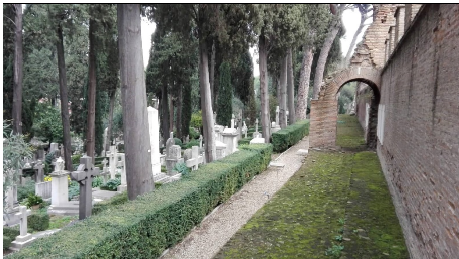
Figura 13. Mura Aureliane, Lo spessore del camminamento di Aureliano riproposto dal restauro del 1975 e il terrapieno del cimitero Acattolico (foto Chiara Baranello, 2017)
