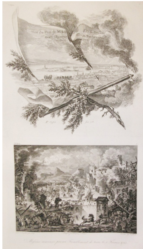
Figura 5. Messine renvers e par un Tremblement de terre le 5 F vrier 1783 (in SAINT-NON, 1781-1786)
