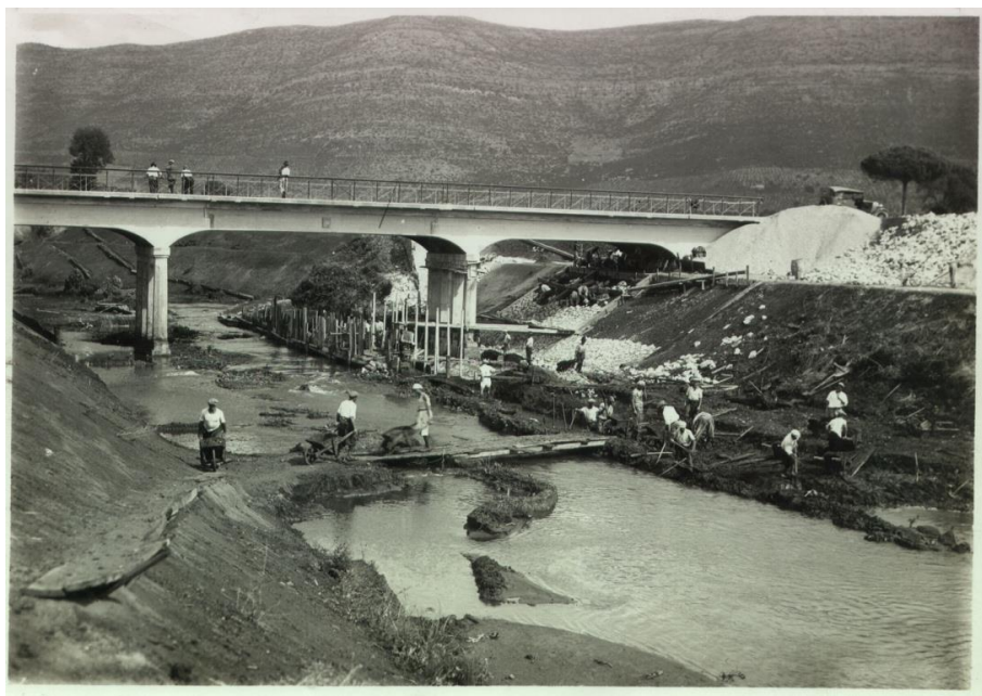
Figura 7. Fiume Amaseno. Sistemazione dell'alveo a valle del ponte di Fossanova e costruzione del rivestimento – briglia sotto il ponte, 1932 (ASL, CBP, Sottoserie Fotografie I, n. 482). La fotografia raffigura gli ingenti lavori di sistemazione idraulica lungo il corso dell'Amaseno per liberare i territori circostanti dalle acque stagnanti e garantire un regolare deflusso idrico della portata del fiume
