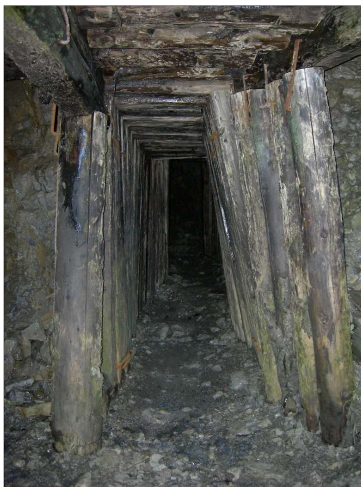
Figura 12. Interno galleria con paleria originale. Costabela S. Pellegrino (foto Pietro Dalprà) Fasi del lavoro di censimento
