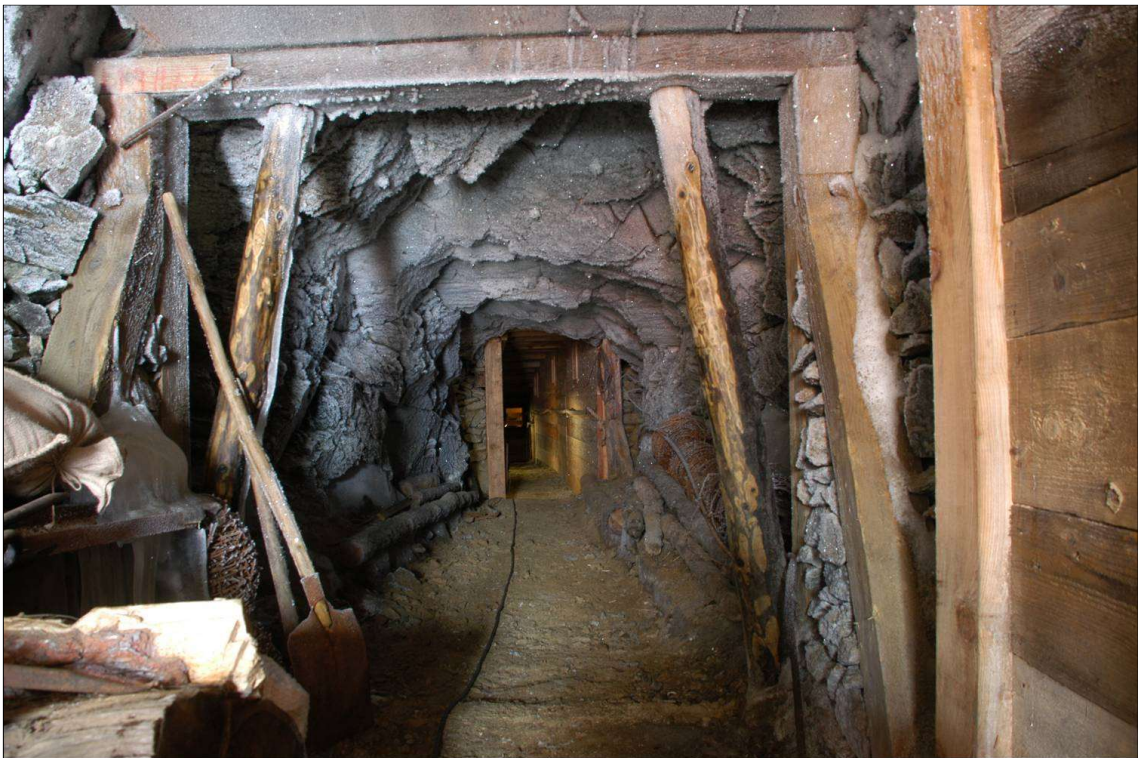
Figura 7. Punta Linke. La galleria artificiale nella parte scavata in roccia. Sono visibili gli apprestamenti minerari originali
