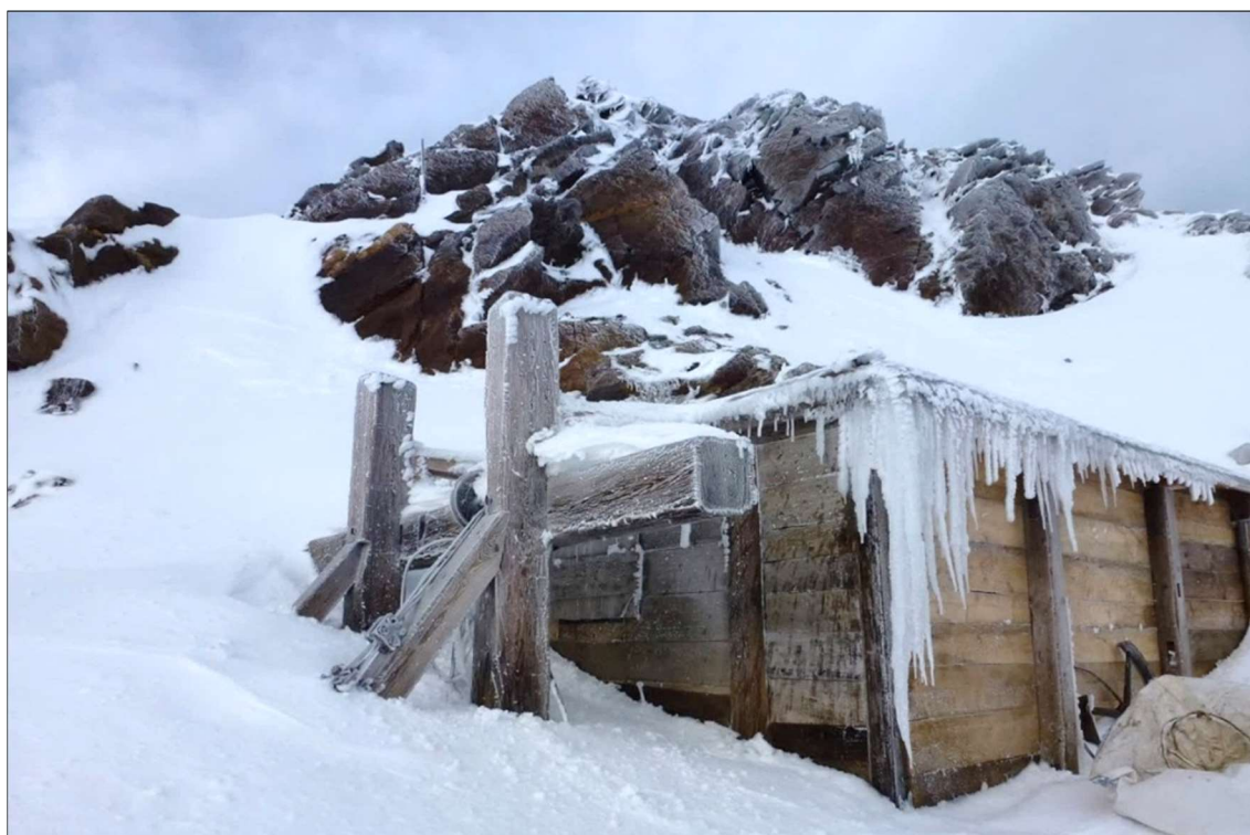
Figura 5. Punta Linke. La baracca con le strutture di arrivo della teleferica
