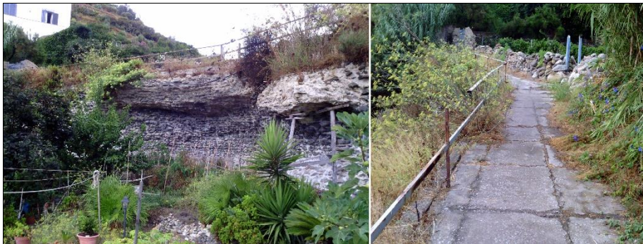
Figura 11. Diga romana a Giancos. Paramento a valle (sinistra), camminamento sul ciglio (destra). Fotografie dell'A.
