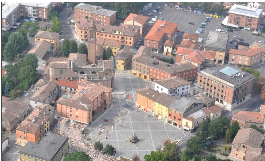
Figura 14. Il centro storico di Cavezzo, (Modena), come appariva il 6 agosto 2012, con danni e successive demolizioni provocati dalla sequenza sismica del maggio-giugno precedenti. La maggior parte degli edifici storici visibili nell'immagine è inagibile o gravemente danneggiata, come rivela una rapida osservazione dei dettagli (coperture danneggiate, serrande chiuse in tutto l'edificio ecc.). Cavezzo è il centro abitato dove si è registrata l'intensità macrosismica più elevata (8 EMS)
