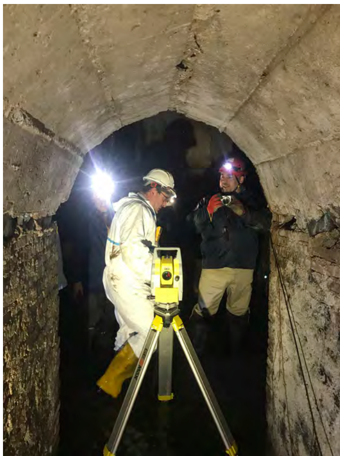
Figura 13. Lavori di esplorazione e rilievo all'interno dell'acquedotto
