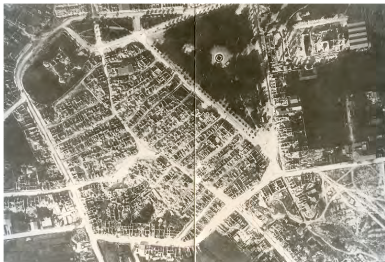
Figura 9. Avezzano, foto aerea dopo il sisma
