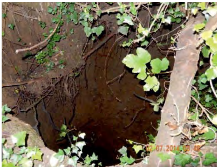
Figura 14. Sinkhole formatosi in località Vignetta, comune di Montelibretti (Roma), nel maggio del 2010 (Argentieri et al., 2015)
