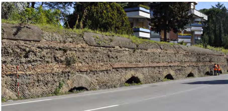
Figura 3. Tratto su arcate di età traianea
