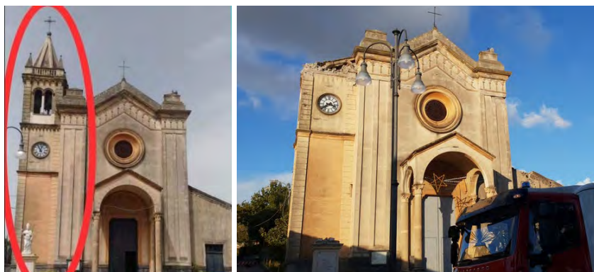
Figura 15. Chiesa di Santa Maria dei Carmelo nella Frazione di Pennisi nel Comune di Acireale (CT) prima del terremoto, a sinistra, e dopo la scossa, a destra: la Statua di Sant'Emidio (protettore dei terremoti) e il campanile, sono crollati
