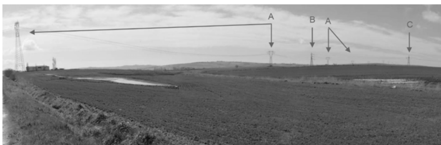
Figura 2 - Nella vasta area agricola sono visibili sostegni della linea a 380 kV "Montalto-Villavalle" (A), i sostegni di interconnessione (B) e di raccordo (C) della suddetta linea con la S.E. Toscana, in fase di realizzazione (Cozzolino, 2013, p. 22)
