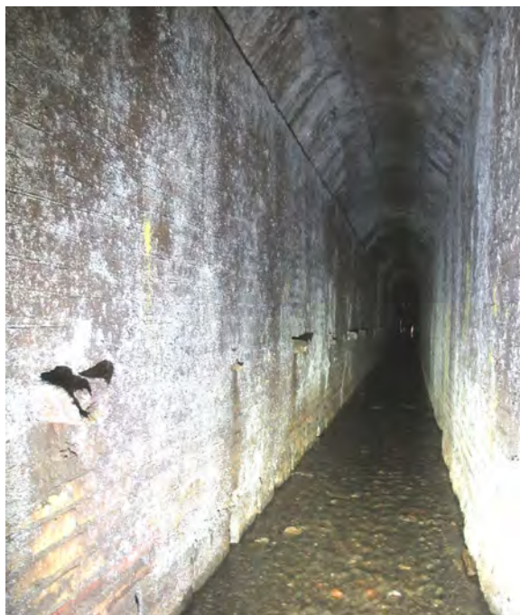
Figura 6. Ramo di captazione delle Sette Botti. Bocchette di immissione realizzate con coppi
