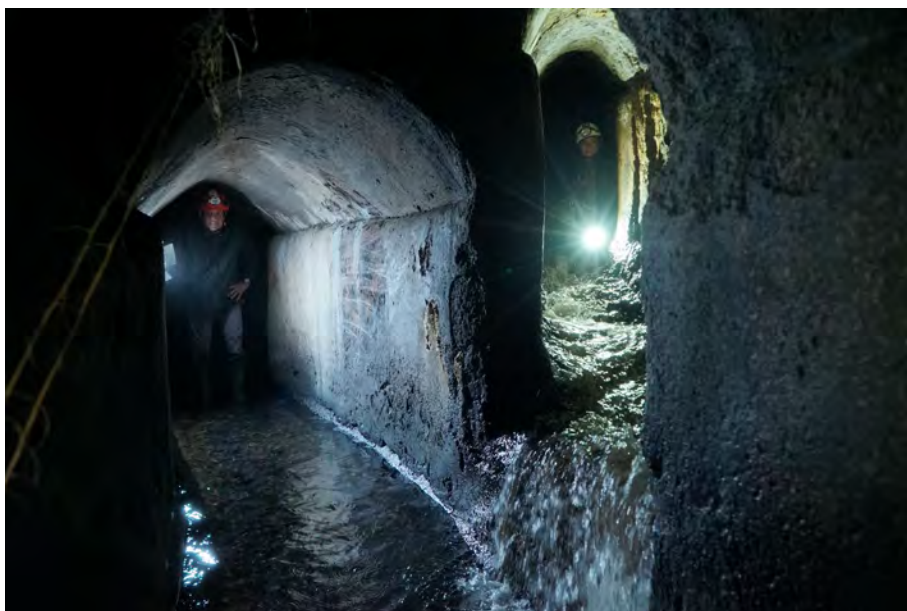
Figura 4. L'immissione nel condotto principale del ramo di captazione delle Sette Botti
