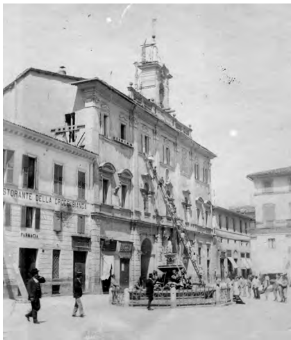
Figura 2. Rieti, Palazzo comunale, operazioni di sgombero. Per gentile concessione Dott. Roberto Lorenzetti
