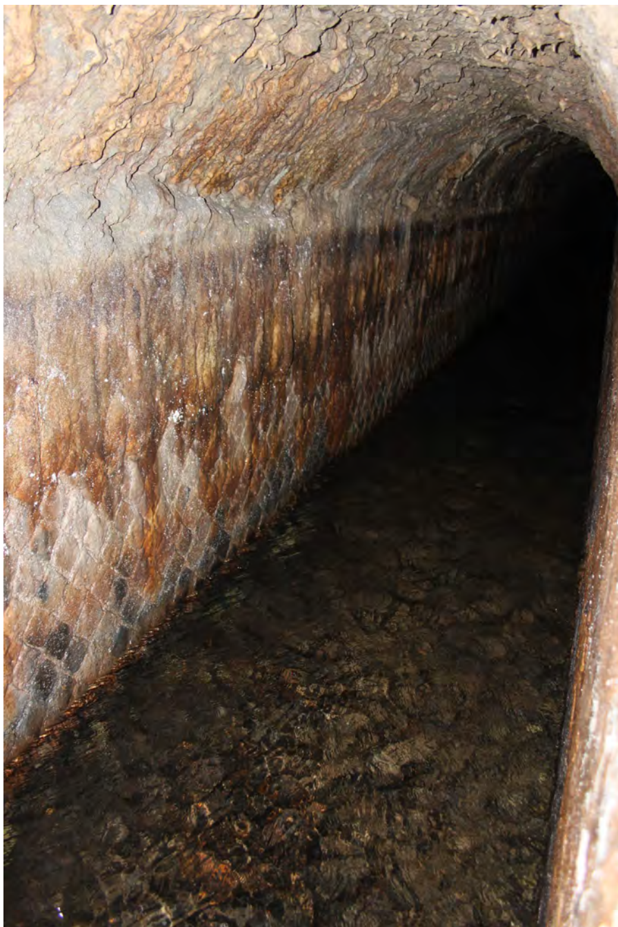
Figura 1. Il condotto principale: tratto in opera reticolata
