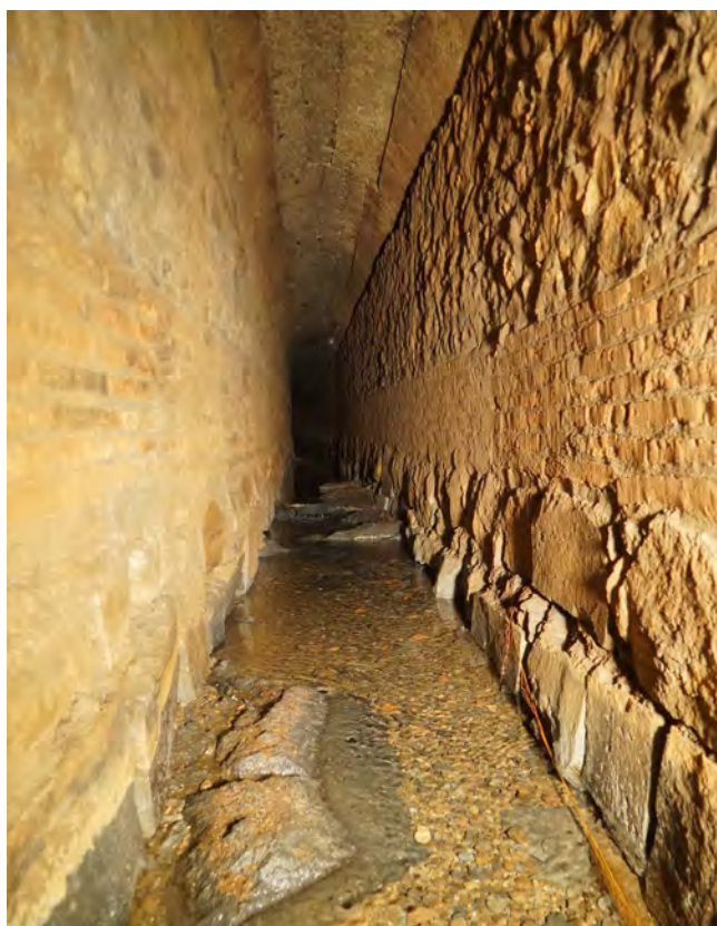
Figura 5. Ramo di captazione delle Sette Botti. Si notano: in alto, la muratura a schegge di leucite; in basso, i blocchi di leucite distanziati per permettere l'entrata dell'acqua nel condotto
