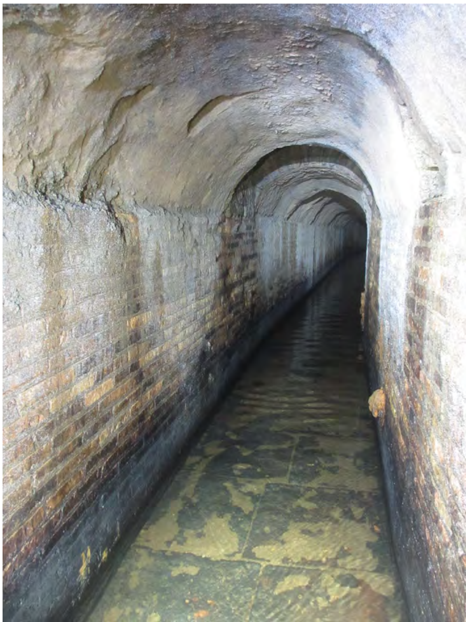
Figura 2. Il condotto principale: tratto in opera laterizia
